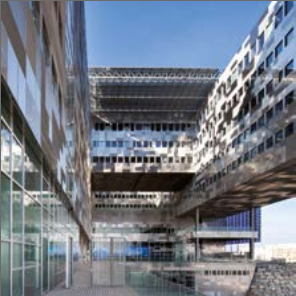
Architectes : Ateliers Jean Nouvel et François Fontès Architecture Photographe : Luc Boegly
