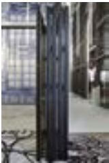
Cache rainures ouvrants : profilé synthétique ou joint acoustique noir
